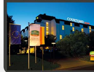
Außenansicht bei Nacht
